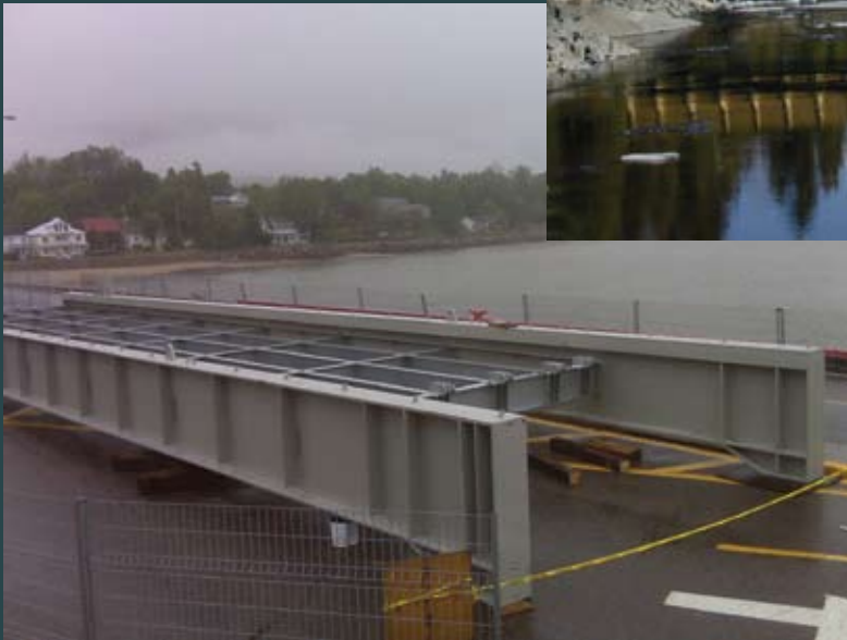
Rampe d'embarquement du traversier à St-Joseph-de-la-Rive
